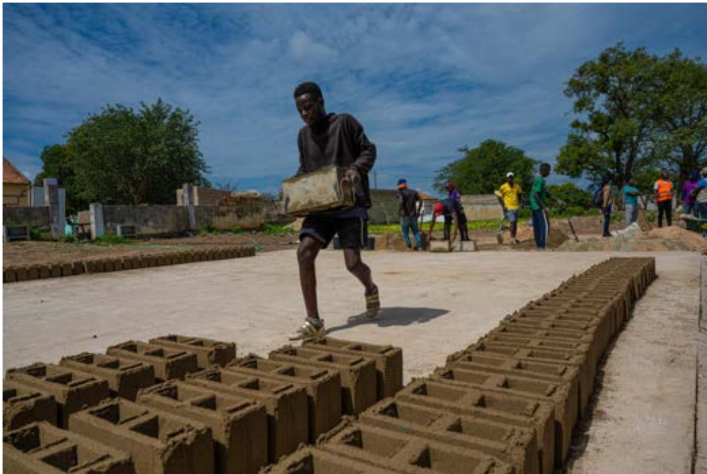
Flavio Luciano Samba bærer former med sand og sement som skal bli til mursteiner.
